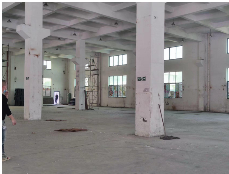
图 2-7 扩建项目厂房现状照片
